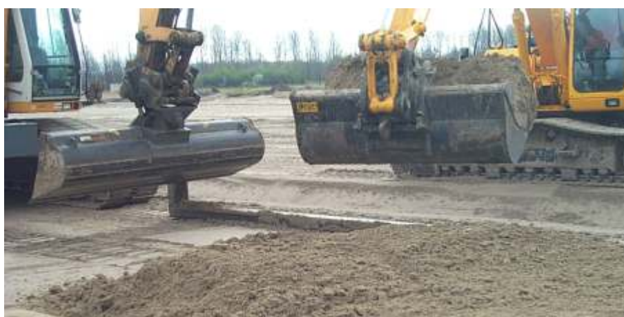
Réglage de l'épaisseur du TRISOPLAST à l'aide d'un guide métallique.
