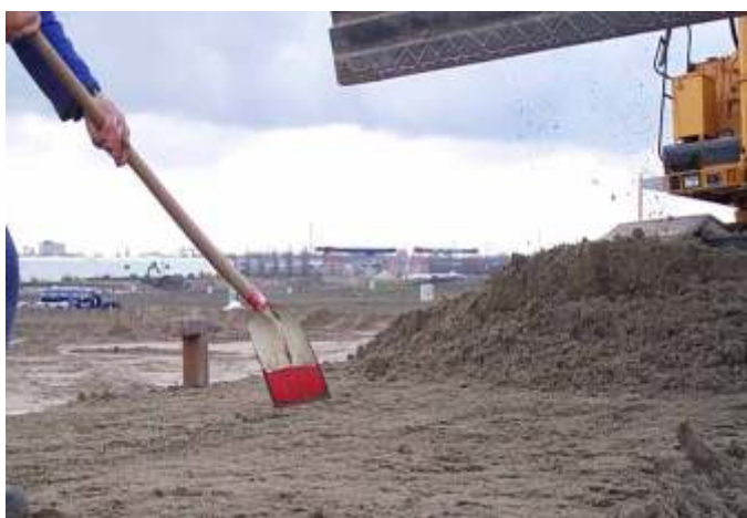
Pose du TRISOPLAST et vérification de l'épaisseur à l'aide d'un pelle.
