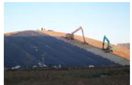
Barrière de fond et Couverture de Centre d'Enfouissement Technique Barrière (passive) minérale en TRISOPLAST et barrière (active) en géomembrane.
