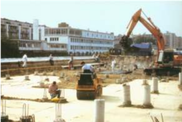
Confinement de pollution avant la construction d'un bâtiment.
