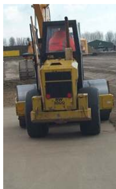
Compactage du TRISOPLAST : aspect final lisse et dur.
